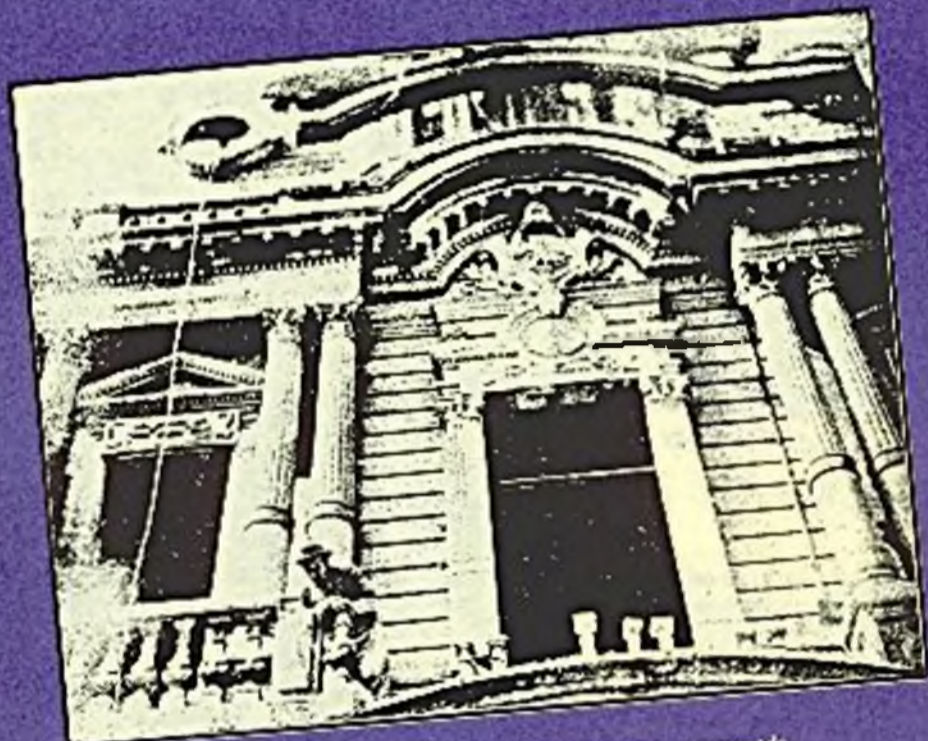
Balcón central del antiguo edificio de la Lotería, comenzada su demolición.
